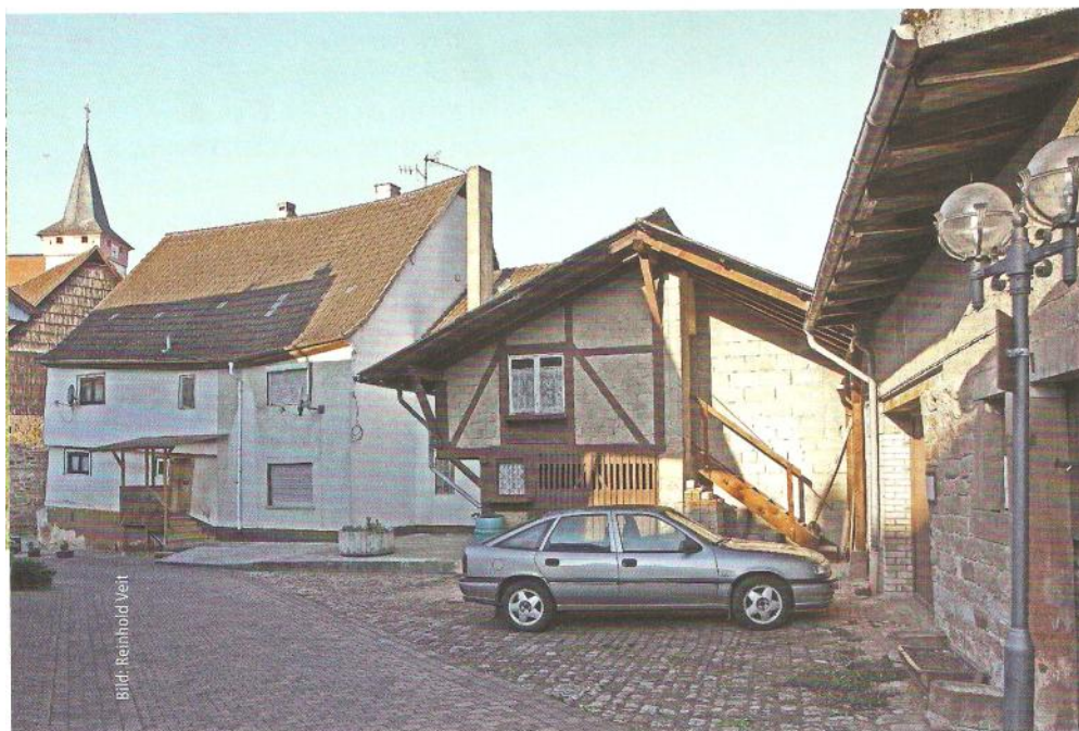
Dieses 400 Jahre alte Fachwerkhaus sollte aus seiner Schräglage von über 70 cm wieder aufgerichtet werden.
